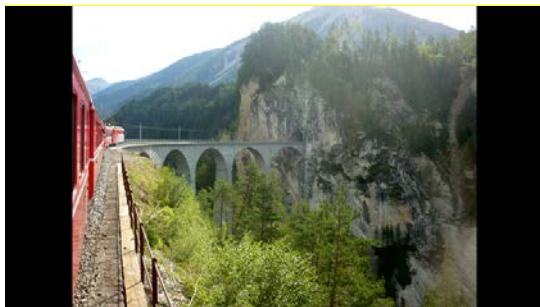
Immagine 3: Viadotto della Ferrovia retica
