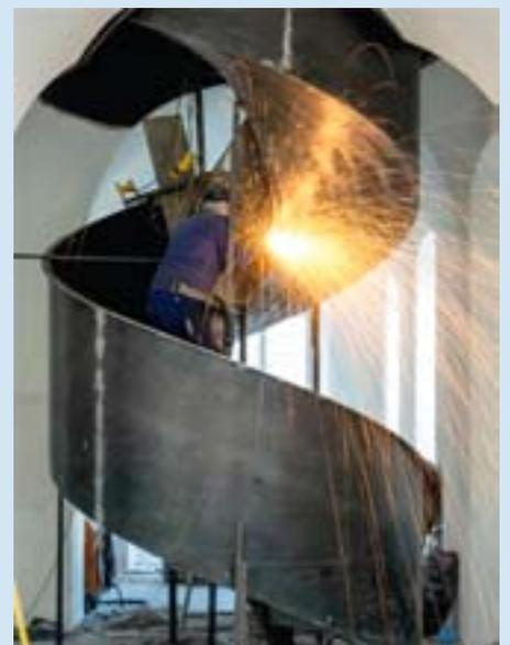
Einbau der Wendeltreppe in die bestehende Gewölbestructur. Bild: zvg
