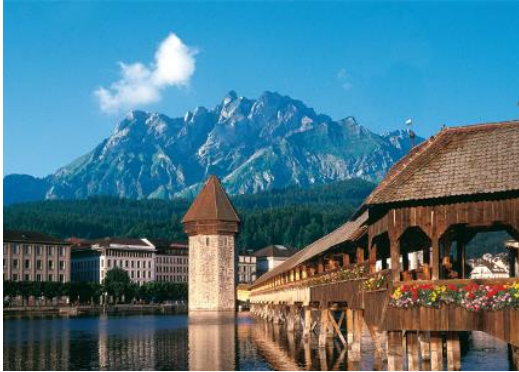
Bild 3: Kapellbrücke in Luzern
