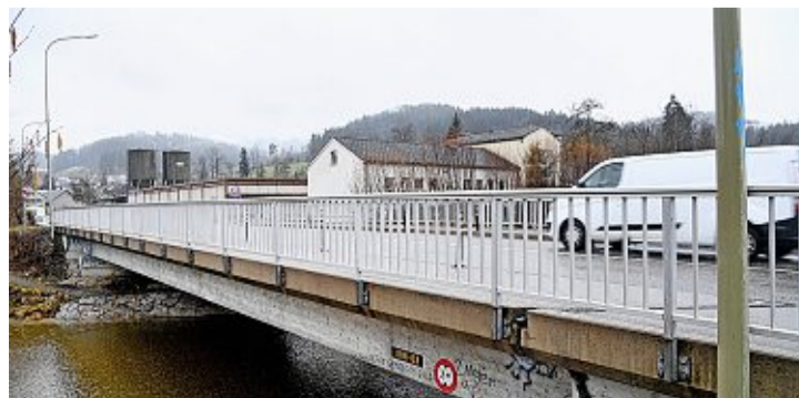
Im Jahr 1952 wurde die Tössbrücke zwischen Turbenthal und Wila erstellt, nun muss sie neu gebaut werden. Foto: Madeleine Schoder
