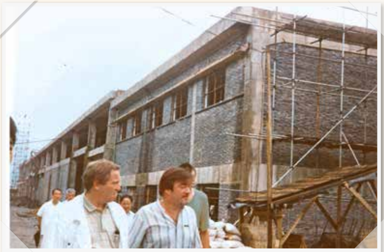
China erwacht: Unternehmer Blocher (l.) beim Baustellenbesuch.
